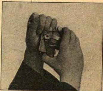
Griff zum Spannen und Entspannen des Schlosses
